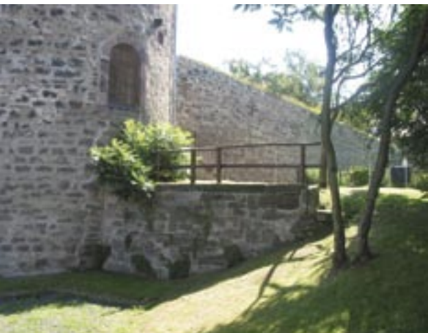
Kahla, Stadtmauer. Stadtmauer und angelagerte Freiräume bieten Aufenthaltsqualität und wirken stadtbildprägend.
