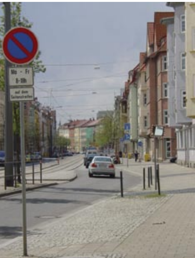
Erfurt, Leipziger Straße. Situation nach der Umgestaltung.
