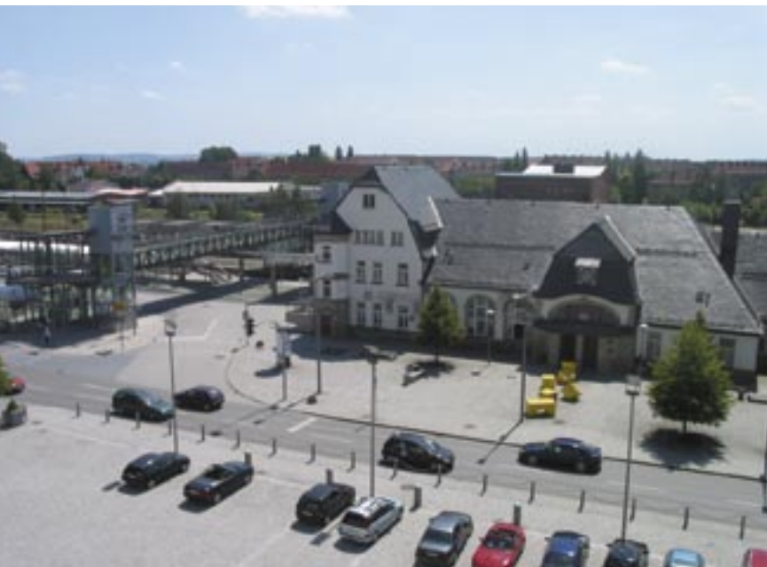
Sonneberg, Bahnhofsvorplatz. Die Situation nach der Umgestaltung. Links im Bild die neue Fußgängerbrücke
