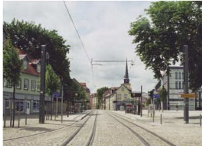
Die Brühler Straße nach der Umgestaltung
