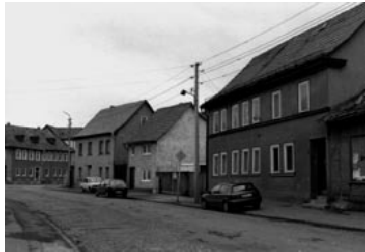
Kranichfeld, B87. Zustand vor und nach Umsetzung der Massnahme.
